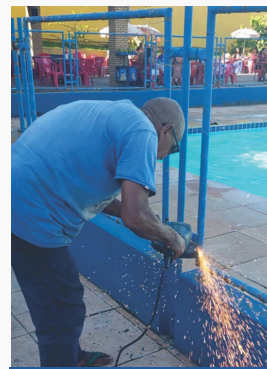
ALAMBRADO PISCINA ANTES
