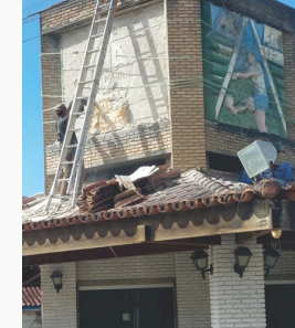
REFORMA DA FACHADA
